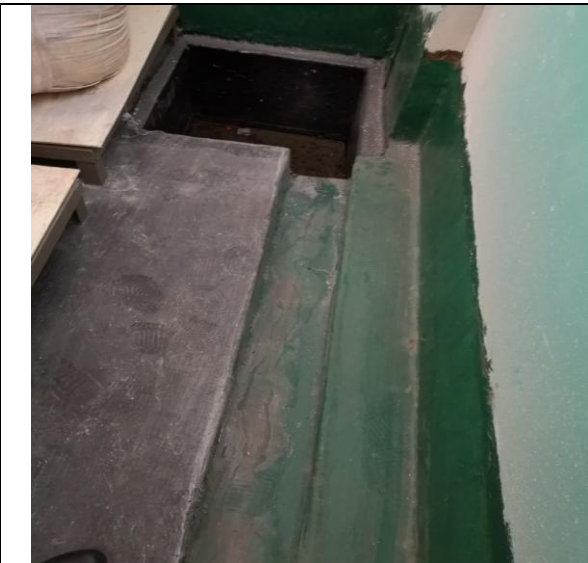
导流槽及集水井
