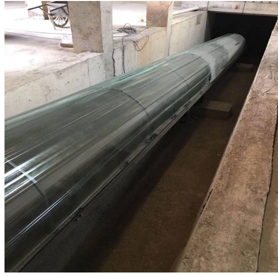
封闭运输廊道
