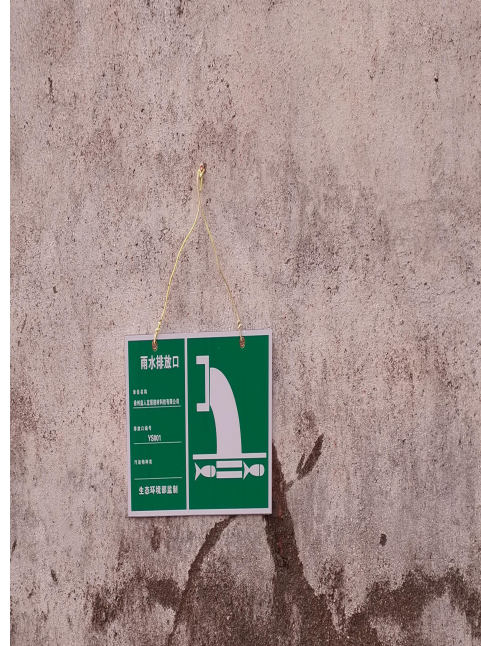
雨水排放口标识牌
