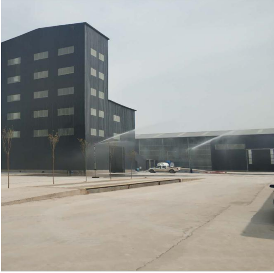
厂区内喷淋设施
