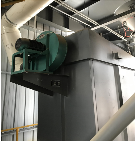
散装机脉冲布袋除尘器
