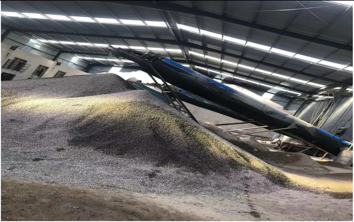
图 3.2-3 封闭输送廊道
