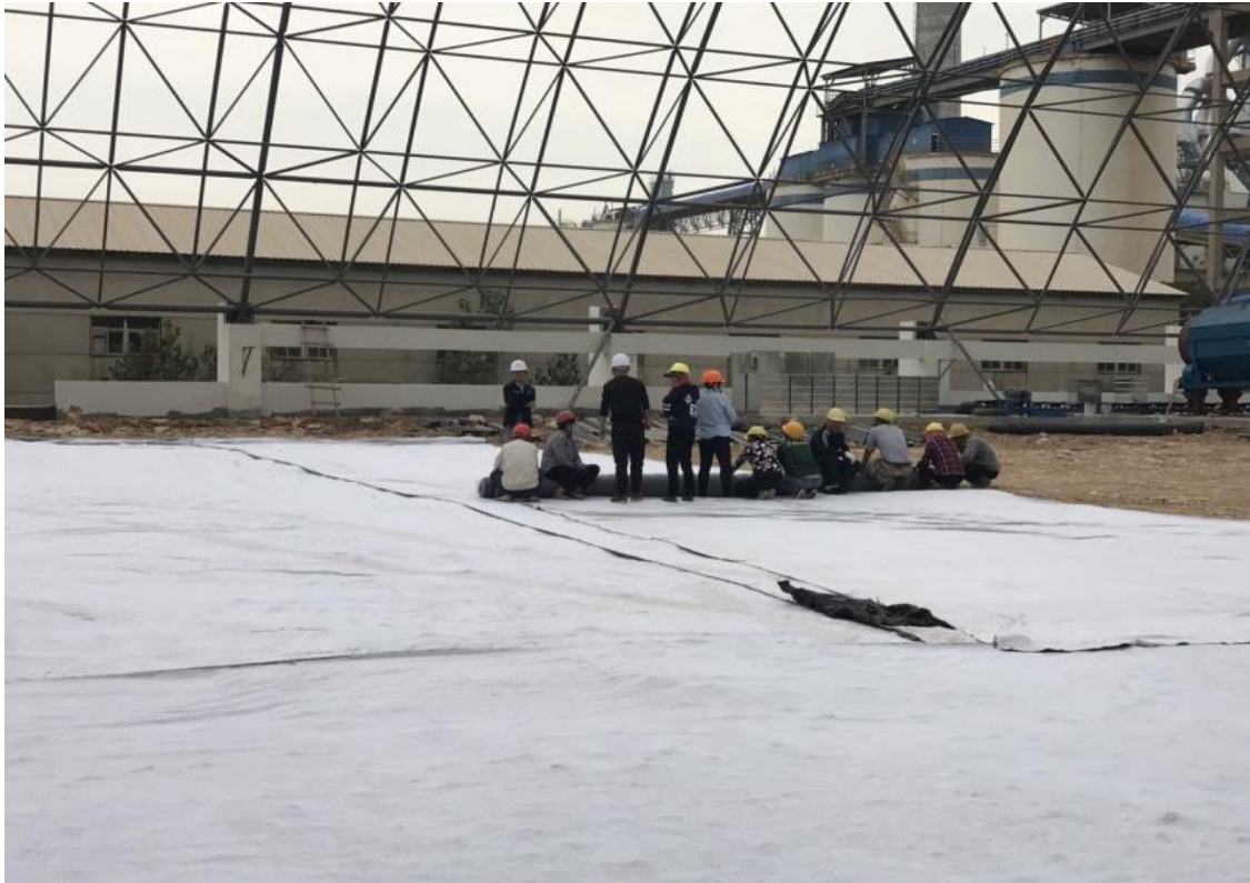
1#暂存库防渗施工图
