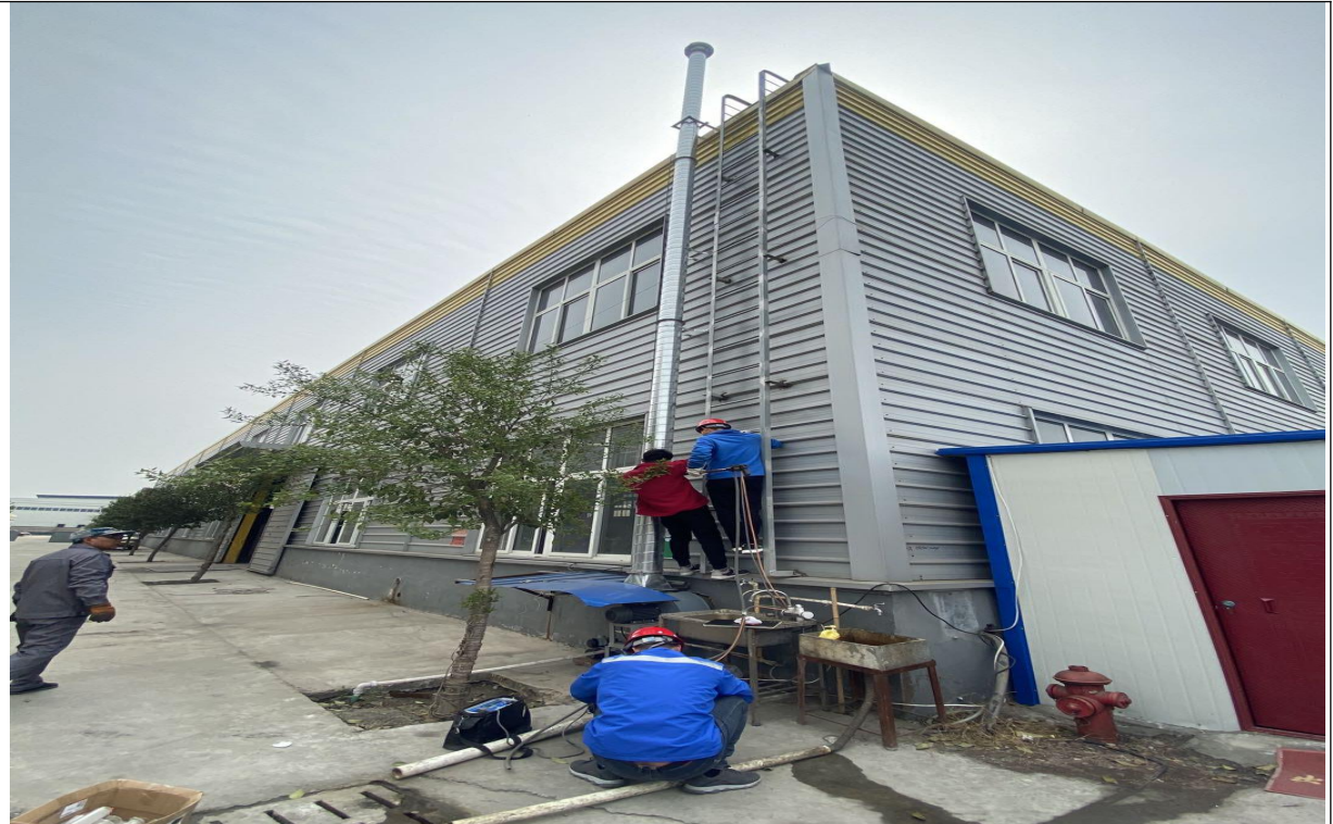
图 3.2-11 浸涂料、烘干工序废气排气筒
