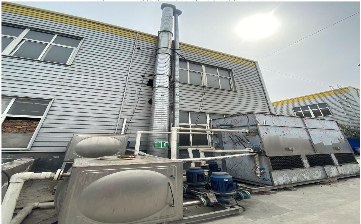
图 3.2-4 熔炼工序排气筒
