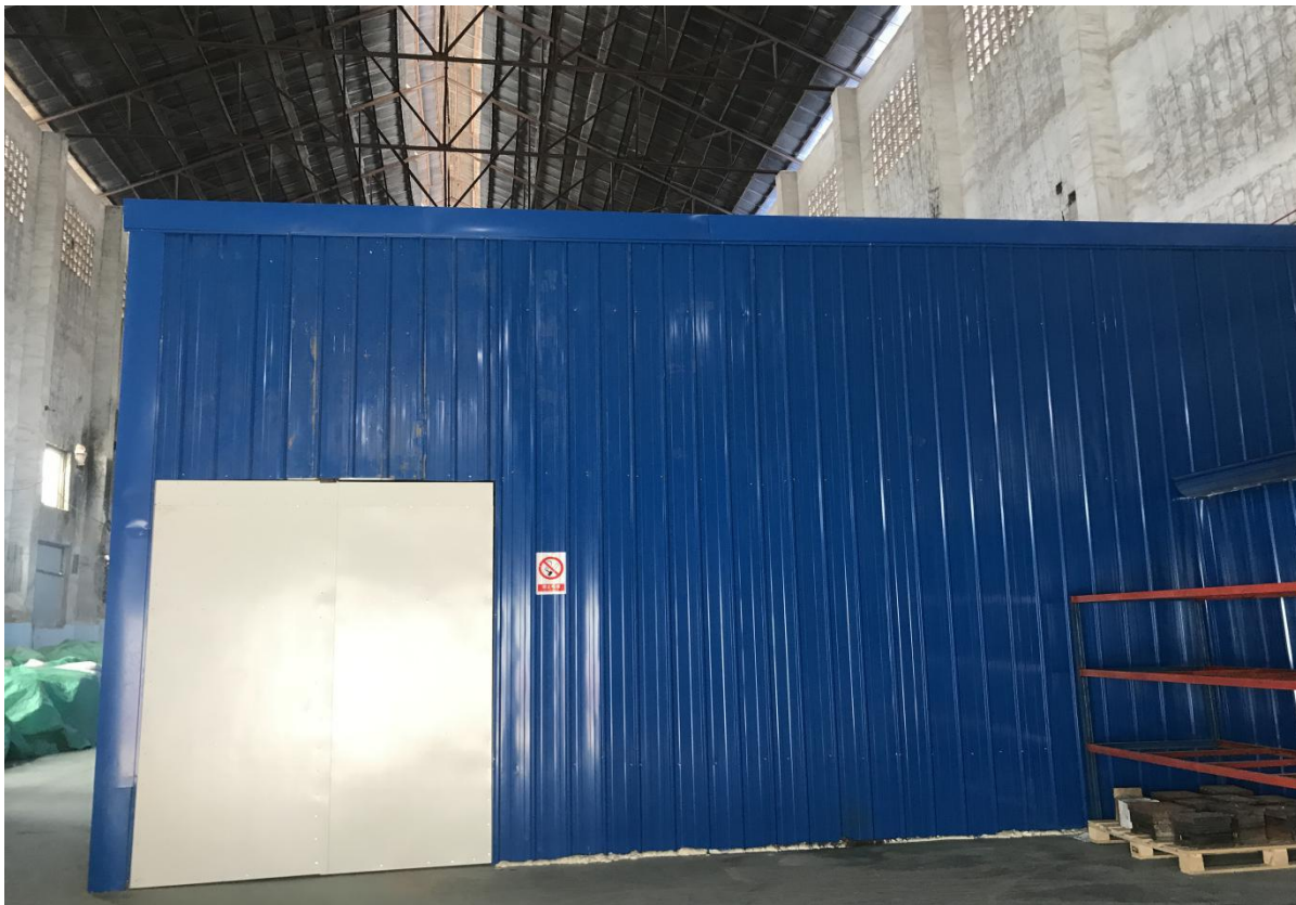
图 3.3-1 封闭注塑生产车间
