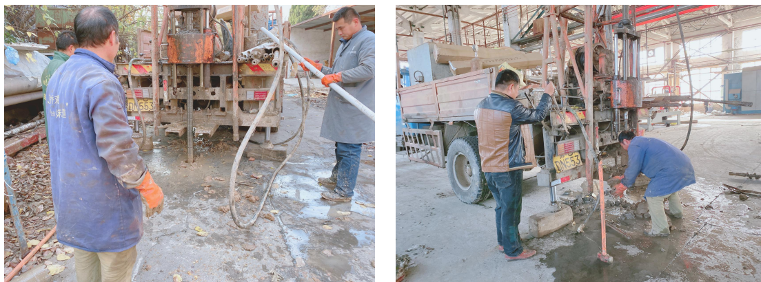
图 7.1-1 场地钻探 DDP-100 型汽车钻机
