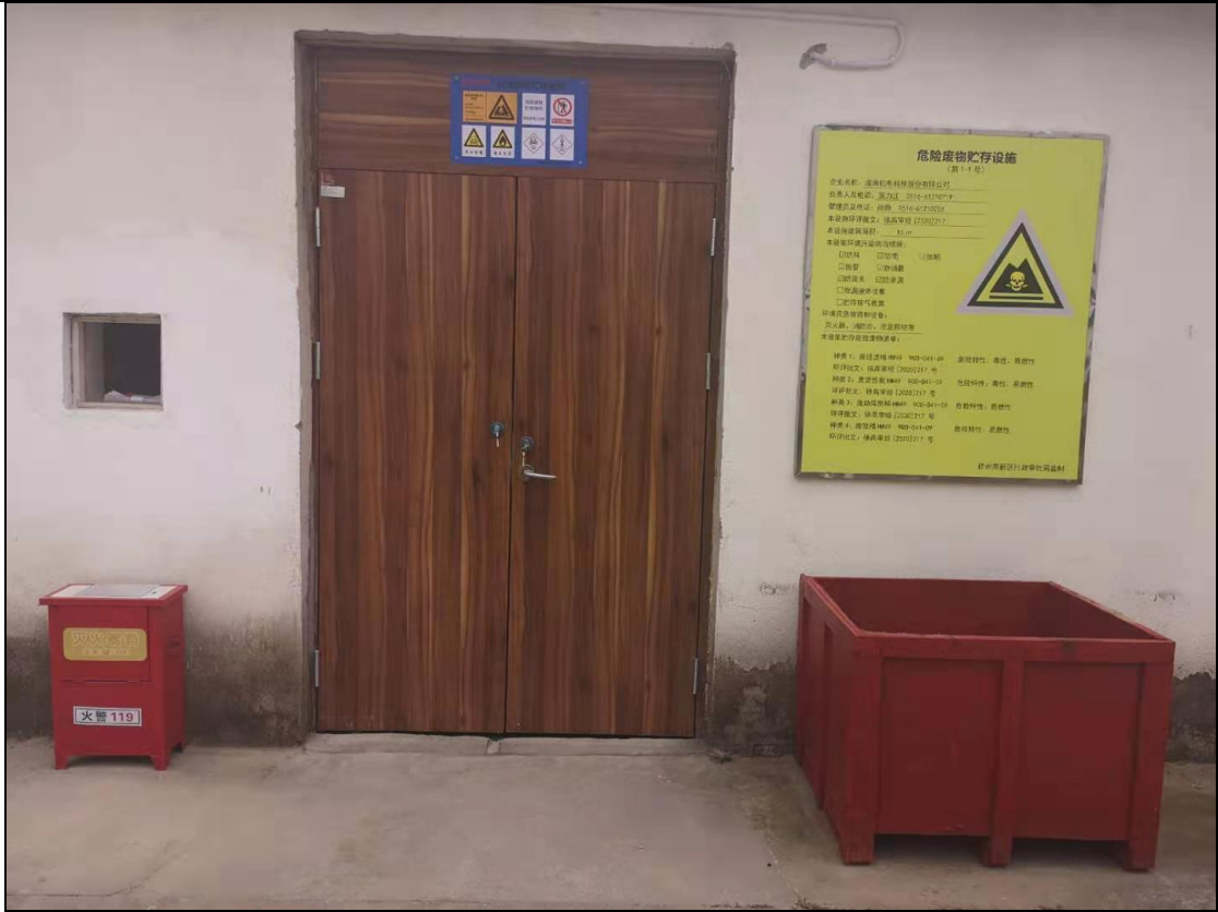
危废库标识牌及消防设施
