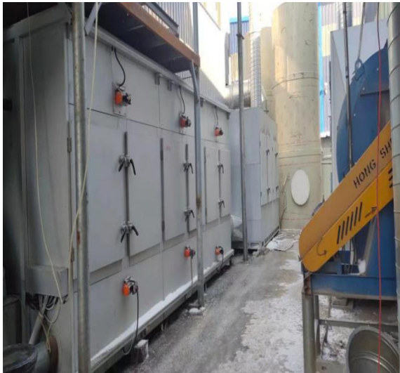
干式过滤箱+活性炭箱 (自动喷涂、晾干废气处理设施)
