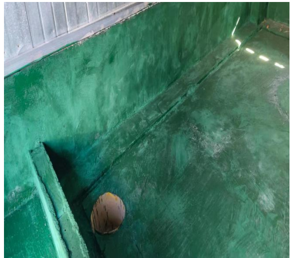
导流槽、集水井
