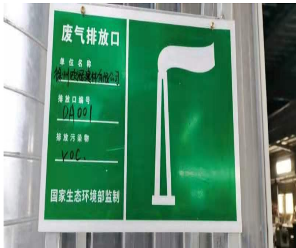
喷涂废气排气筒标识牌
