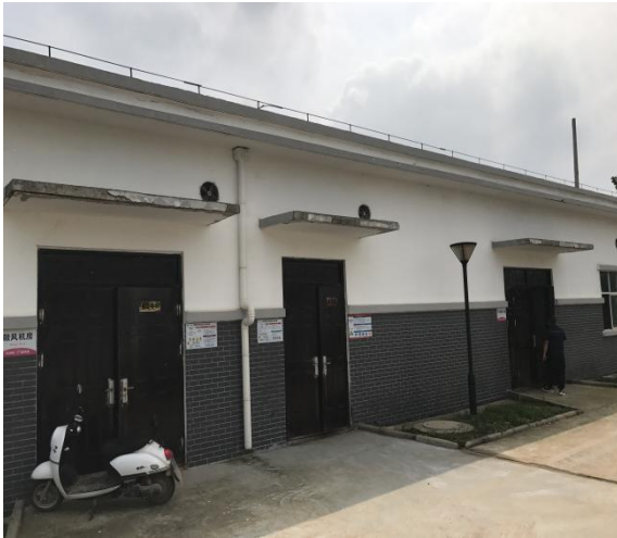
封闭鼓风机房及污泥脱水机房
