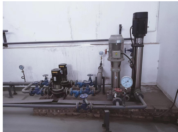
车间隔声、减振基础
