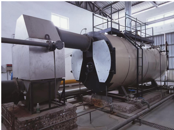
车间隔声、减振基础
